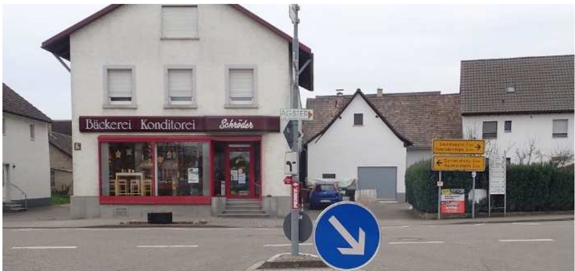
Bild 1: Sanierungsobjekt Würmersheimer Straße 6
