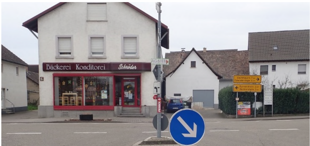
Bild 1: Sanierungsobjekt Würmersheimer Straße 6
